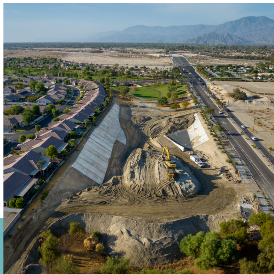
Proyecto Regional de Control de Inundaciones de North Indio
