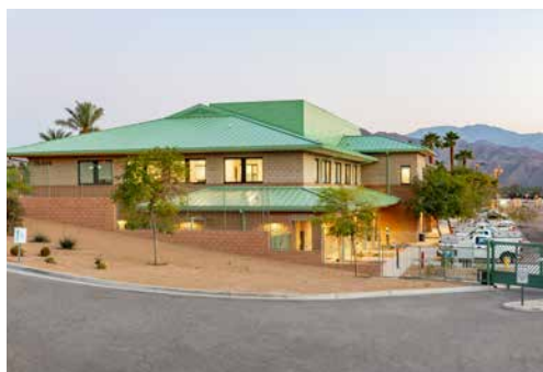
Edificio de Servicios de Soporte crítico
