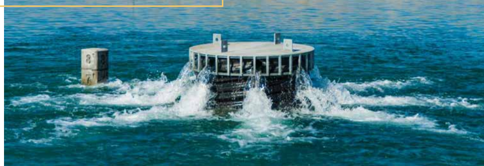
Instalación de reposición de aguas subterráneas de Palm Desert
