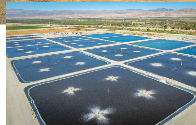
Planta de reciclaje de aguas residuales 4
